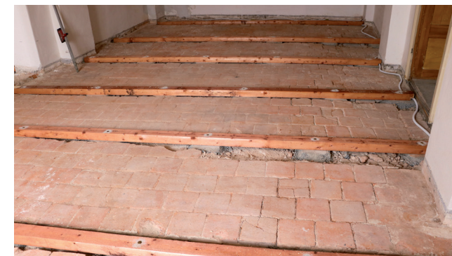
Očištěná podlaha s novým rostem v druhé výstavní místnosti
